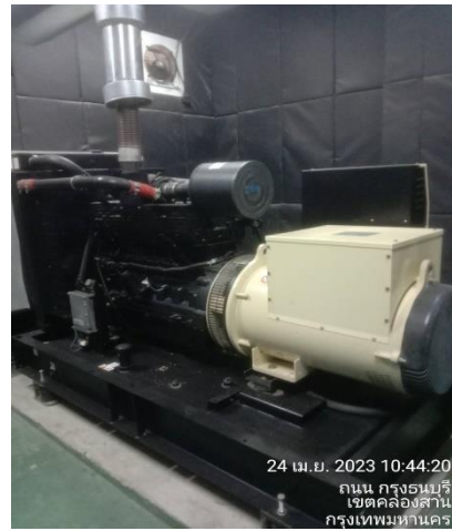
ภาพที่ 19 เครื่องกำเนิดไฟฟ้าสำรอง
